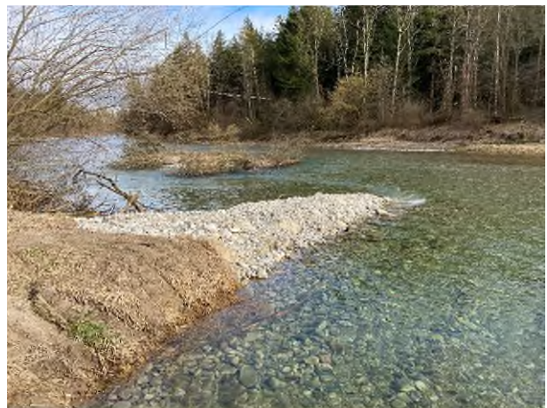
Abb. 2: Naturnah gestalteter Strömungsteiler mit Zugangsmöglichkeit vom Uferweg.
