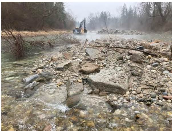
Abb. 1: Ein Bagger baut große Mengen Sicherungssteine aus der Gewässersohle aus. Im Vordergrund, eine Insel mit Wurzelstöcken im Bau.
