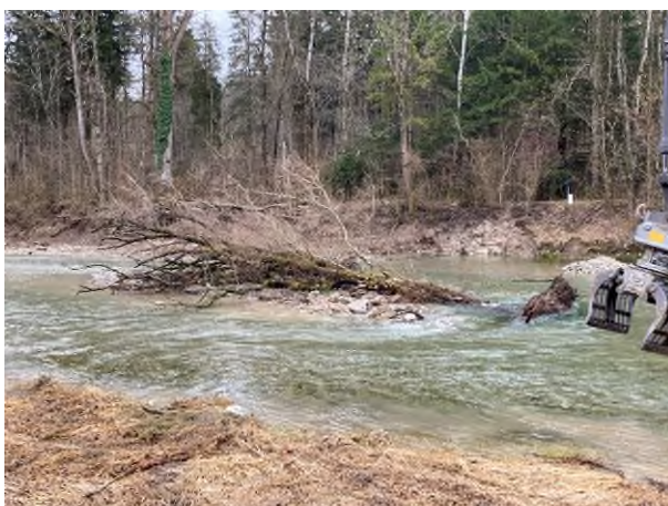
Abb. 3: Mit dem Bagger wurde eine große Weide im Fluss verankert
