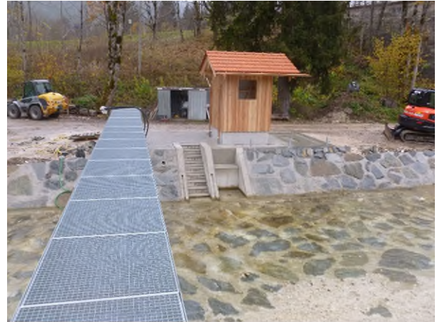
Abb. 2: Das neue Pegelhäuschen steht auf einem hohen Betonsockel und kann einem 100-jährlichen Hochwasser standhalten. Neu gebaut sind auch die Pegeltreppe und die Pegelnische, in der die Drucksonde zum Messen des Wasserstandes eingebaut ist. Foto: Wasserwirtschaftsamt Traunstein
